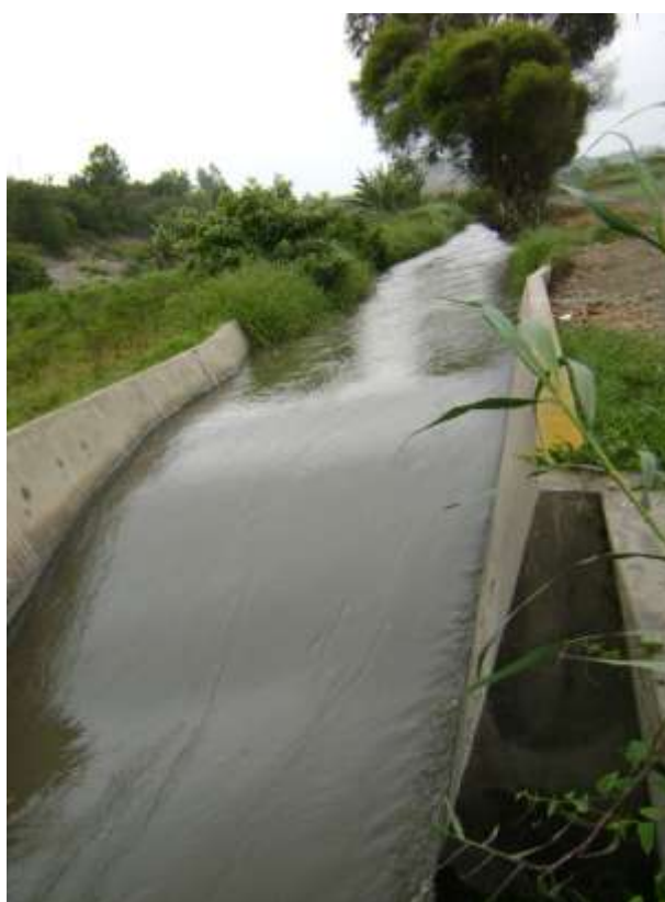
Medidor RBC CD Galpon – Valle Pativilca
