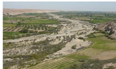
Vista fotográfica del Rio Colmatado que requiere descolmatacion, requiere construir dique con material propio para proteger los cultivos de alfalfa y otros.
