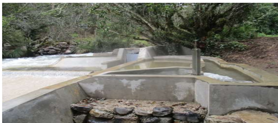
Foto: Bocatoma construida, en la Quebrada Ingenio
