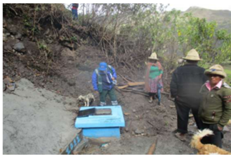
Foto: Manantial Nillpu Kucho, Sector Machahuayo, localidad Salapampa, distrito Llumpa, provincia Mariscal Luzuriaga. Fuente: Verificación Técnica de Campo de fecha 30 de enero de 2023
