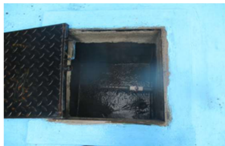
Foto: Interior de caja de captación donde se observa tubería de línea de conducción. Fuente: Verificación Técnica de Campo de fecha 30 de enero de 2023
