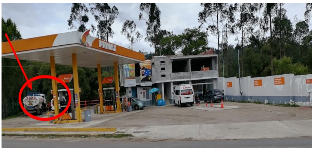
Foto N° 01: Instalaciones del grifo “Primax”, lavado de vehículos en la parte izquierda de la imagen.
