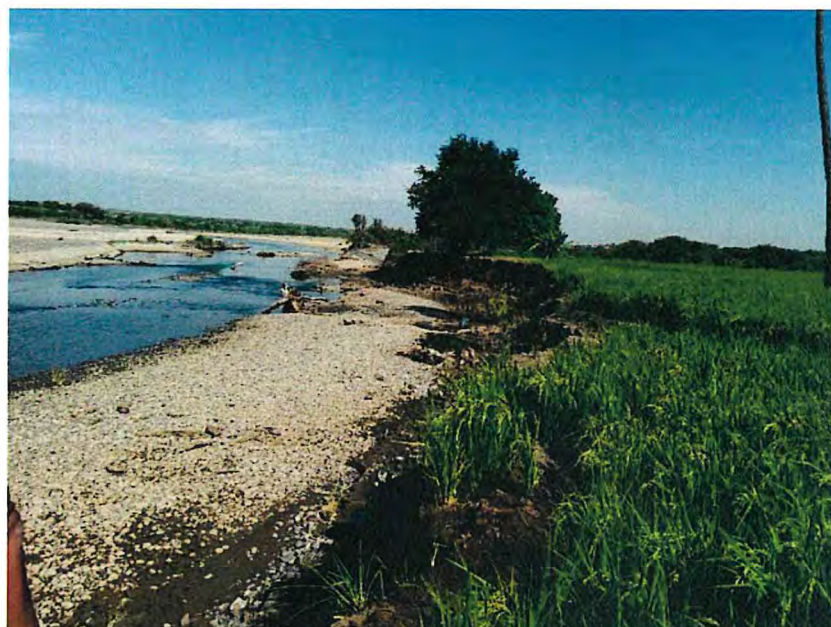
Figura 3. Vista panorámica tomada aguas abajo del río Chira. Se puede observar depósitos fluviales compuesto de gravas y arenas. En la margen derecha se observa la erosión ribereña producida por el río durante las crecidas
