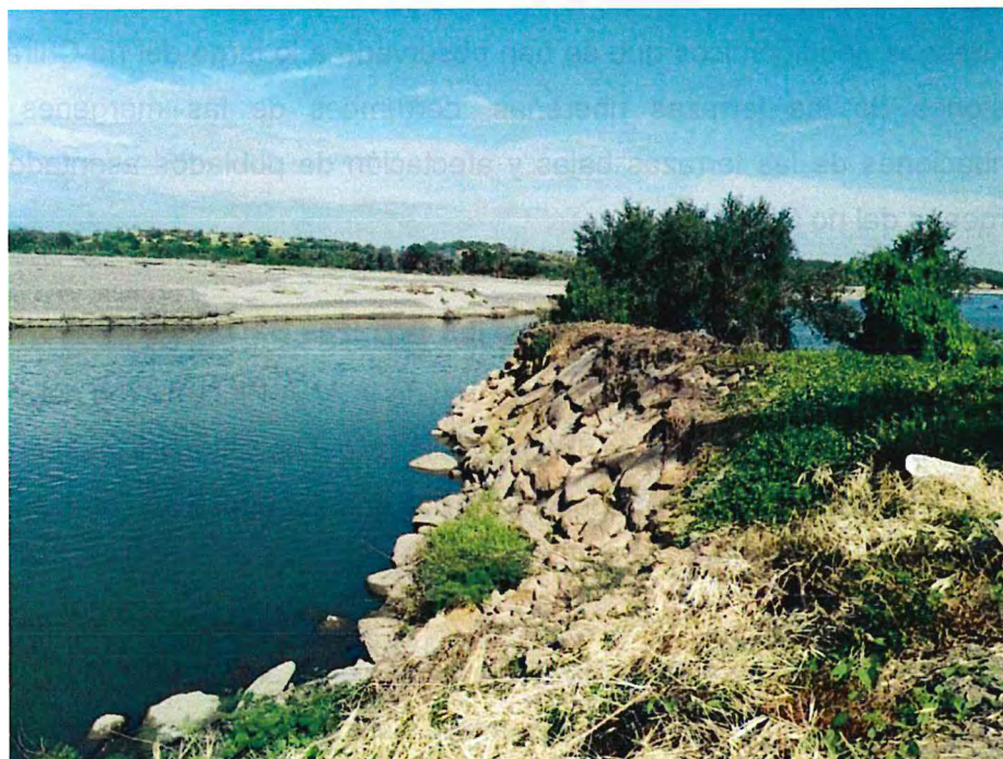
Figura 5. Sector en donde se observa muro de enrocado construido a fin de evitar la erosión de laderas e inundación. Este lugar se encuentra aguas abajo de la Presa de Poechos. Se observa la roca de arenisca grande colocada al volteo
