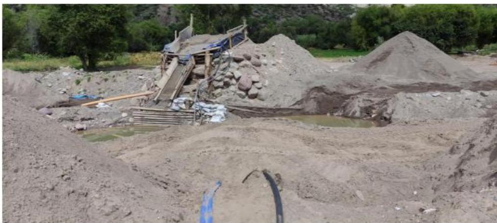
**FOTO 05: AREA DE INTERVENCION EN LA QUE SE APRECIA LA TOLVA ARTESANAL Y LA UTILIZACION DEL AGUA**
