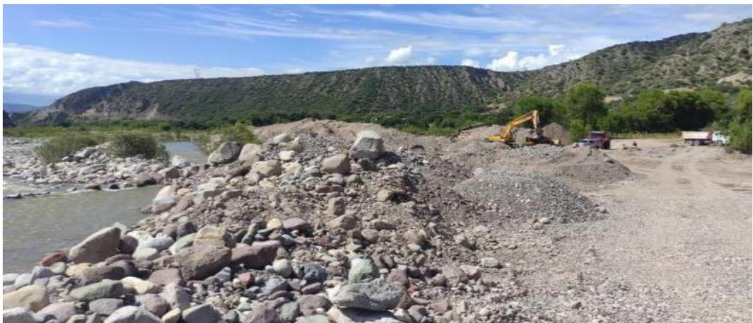
FOTO 08: AREA DE INTERVENCIÓN EN LA QUE SE APRECIA LA COLOCACIÓN INADECUADA DEL MATERIAL DE DESCARTE EN EL CAUCE DEL RÍO
