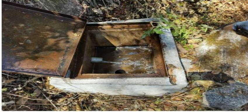
FOTO 04: VISTA DE LA EJECUCION DE LAS OBRAS HIDRAULICAS, TIPO CAJA DE 0.40X0.40M, H=0.40M SIN EL CORRESPONDIENTE AUTORIZACION, EN LA BASE DE LA QUEBRADA HUERTA HUAYCCO.
