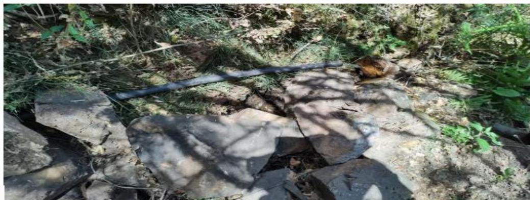
FOTO 03: VISTA DEL SISTEMA DE CONDUCCION TUBERIA HDPE Ø 1”, LOCALIZADA EN LA BASE DE LA QUEBRADA HUERTA HUEYCCO.
