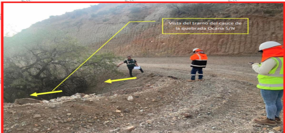
**FOTO 06: VISTA DE LA OCUPACION DE CAUCE DE LA MISMA QUEBRADA OCANA S/N, POR LA ACUMULACION Y CONFORMACION DE LA PLATAFORMA DE LA VIA (TROCHA CARROZABLE) DE 17.8X8.30M H= 1-3.5M APROXIMADOS, CON MATERIAL DESMONTE TIERRA, GRAVA Y CASCAJO.**
