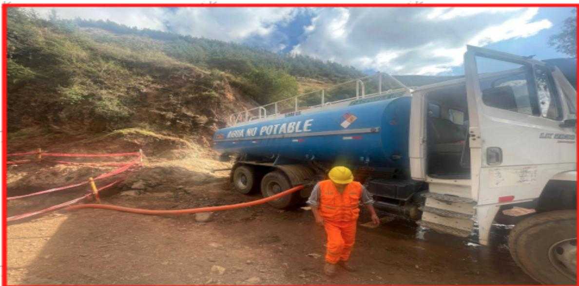
**FOTO 03: VISTA DEL USO DEL AGUA DE LA FUENTE HIDRICA QUEBRADA ALFAHUAYCCO, PARA FINES CONSTRUCTIVO, RIEGO DE VIAS EN LA OBRA.**
