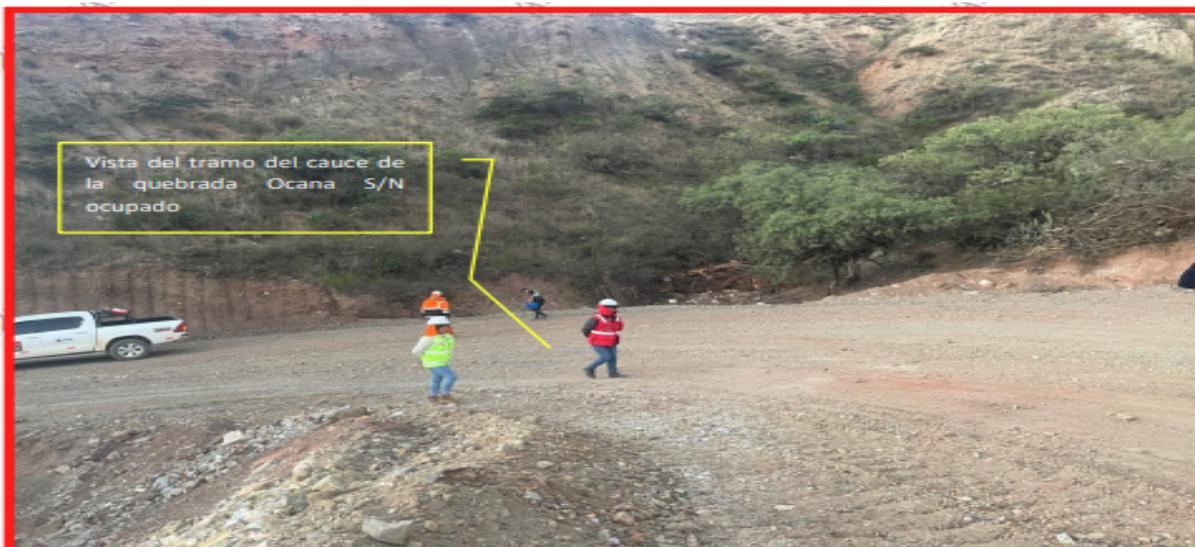
**FOTO 08: VISTA DE LA OCUPACION DE CAUCE DE LA MISMA QUEBRADA OCANA S/N, POR LA ACUMULACION Y CONFORMACION DE LA PLATAFORMA DE LA VIA (TROCHA CARROZABLE) DE 17.8X8.30M H= 1-3.5M APROXIMADOS, CON MATERIAL DESMONTE TIERRA, GRAVA Y CASCAJO.**
