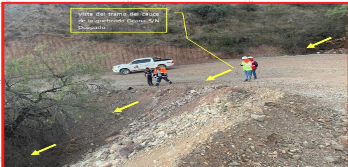
FOTO 05: VISTA DE LA OCUPACION DE CAUCE DE LA MISMA QUEBRADA OCANA S/N, POR LA ACUMULACION Y CONFORMACION DE LA PLATAFORMA DE LA VIA (TROCHA CARROZABLE) DE 17.8X8.30M H= 1-3.5M APROXIMADOS, CON MATERIAL DESMONTE TIERRA, GRAVA Y CASCAJO.
