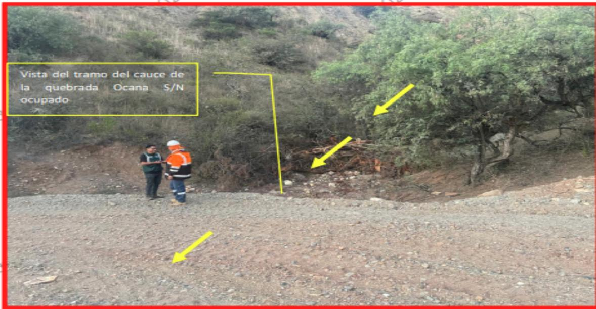
**FOTO 07: VISTA DE LA OCUPACION DE CAUCE DE LA MISMA QUEBRADA OCANA S/N, POR LA ACUMULACION Y CONFORMACION DE LA PLATAFORMA DE LA VIA (TROCHA CARROZABLE) DE 17.8X8.30M H= 1-3.5M APROXIMADOS, CON MATERIAL DESMONTE TIERRA, GRAVA Y CASCAJO.**
