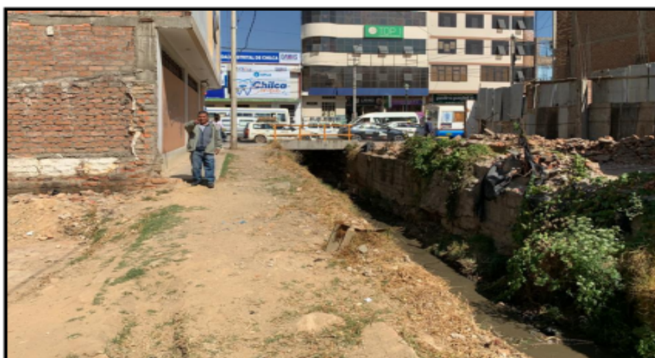
Fotografía 01: se aprecia el predio invadiendo faja marginal
