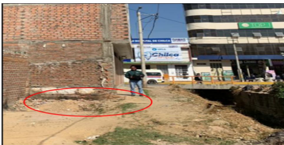
Fotografía 02: se aprecia el predio invadiendo faja marginal
