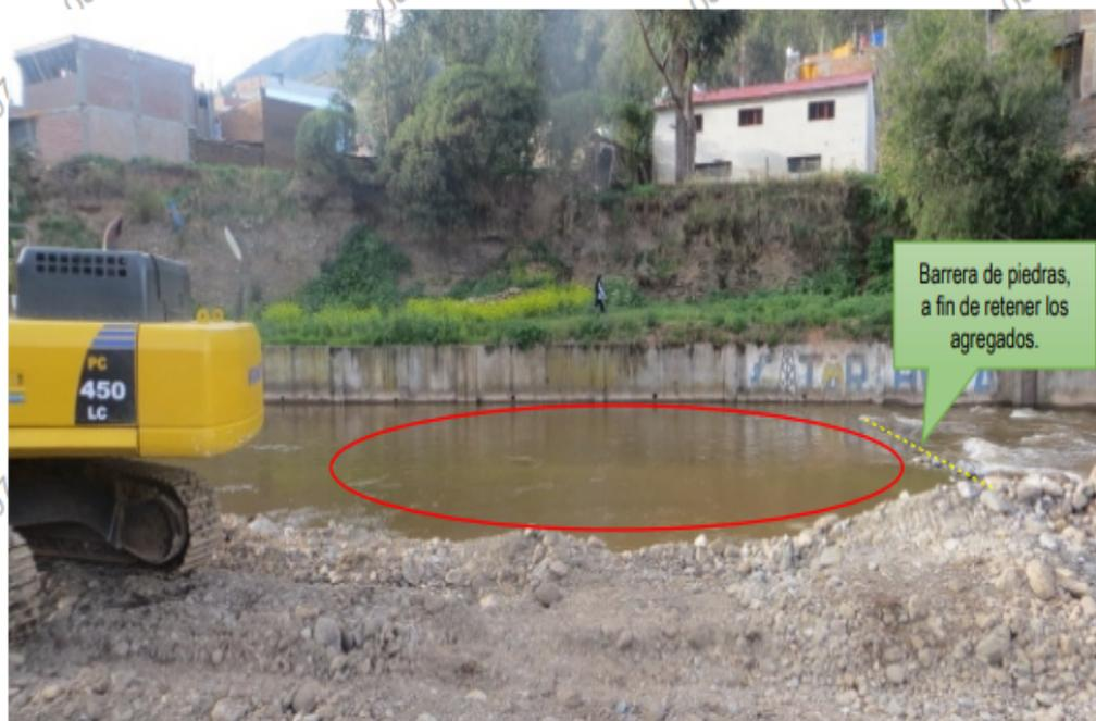
Fotografía N° 05: En la margen derecha del río Ichu, a espaldas del INPE Huancavelica, se observa 01 forado de 20 m x 10m x 2 m de profundidad.
