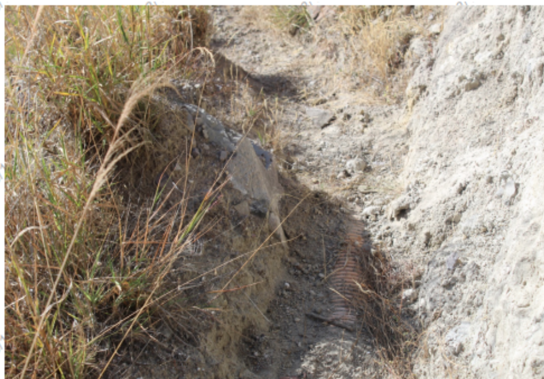
Fotografía N°4: Tubería corrugada para el vertimiento del agua residual
