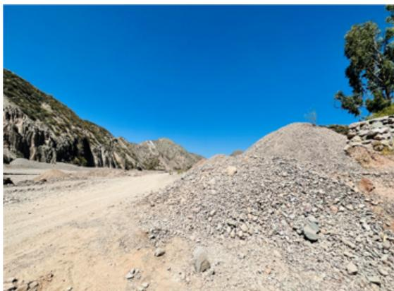
FOTO 01: AREA DE INTERVENCION EN LA QUE SE APRECIA EL MATERIAL DE DESCARTE OCUPANDO EL CAUCE
