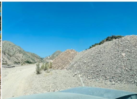
FOTO 03: AREA DE INTERVENCION EN LA QUE SE APRECIA EL MATERIAL DE DESCARTE OCUPANDO EL CAUCE
