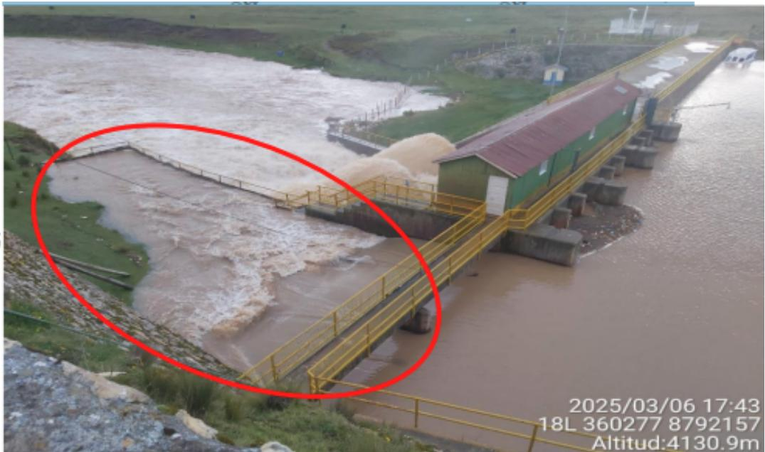
**Fotografía N° 03:** Parte de las aguas del embalse del lago Chinchaycocha son derivadas por el aliviadero de demasías
