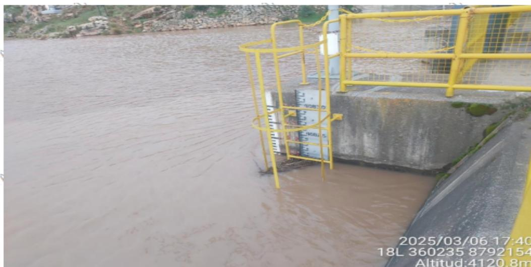
**Fotografía N° 01: Regla limnimétrica en la presa Upamayo**
