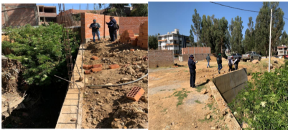
Fotografía 02: se aprecia el muro de contención en faja marginal
