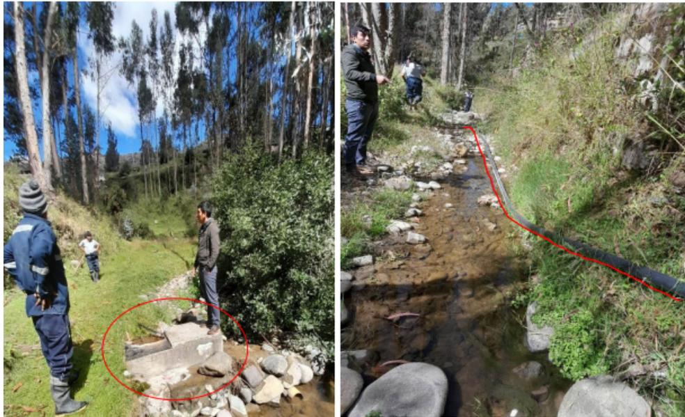
Imagen N° 06 y 07: Manguera de 2 pulgadas que conduce las aguas del riachuelo Tororumi – Huallpahuasi hacia un reservorio de concreto
