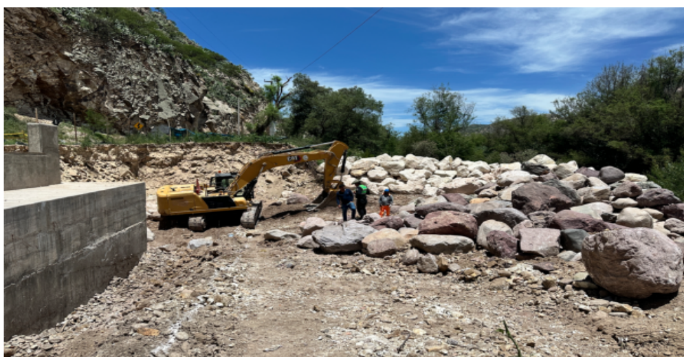
FOTO 03: AREA DE INTERVENCION EN LA QUE SE APRECIA, EXCAVACIONES Y COLOCACION DE PIEDRAS EN EL CAUCE DEL RIO POR PARTE DEL GOBIERNO REGIONAL DE AYACUCHO
