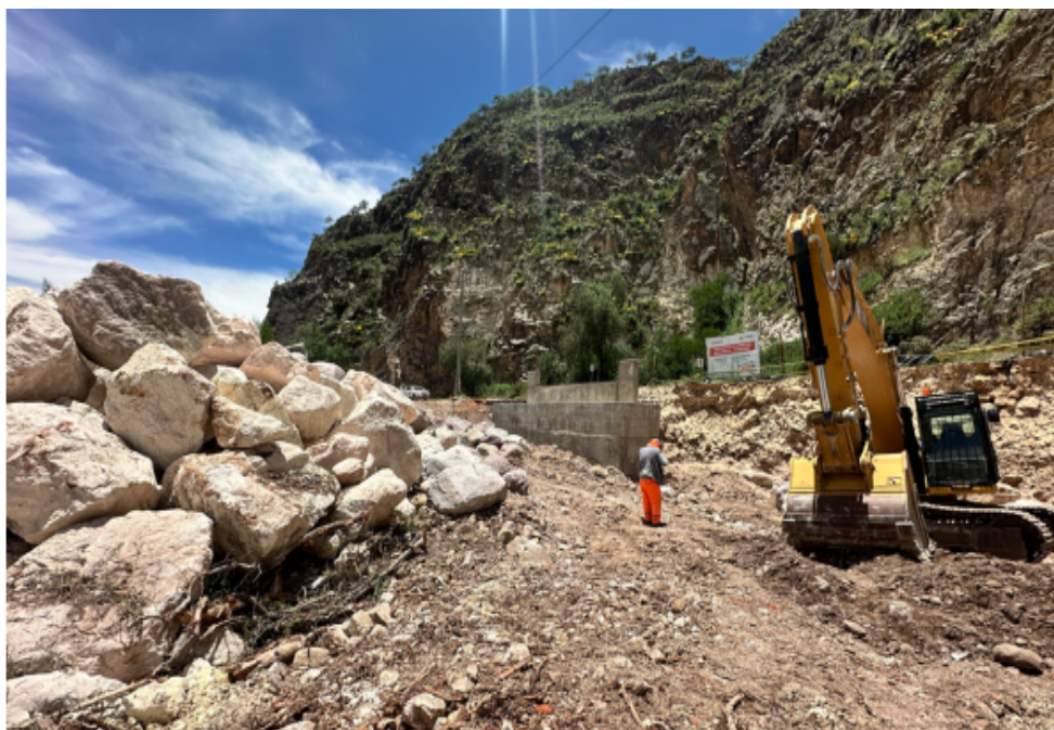
FOTO 02: AREA DE INTERVENCION EN LA QUE SE APRECIA, EXCAVACIONES Y COLOCACION DE PIEDRAS EN EL CAUCE DEL RIO POR PARTE DEL GOBIERNO REGIONAL DE AYACUCHO
