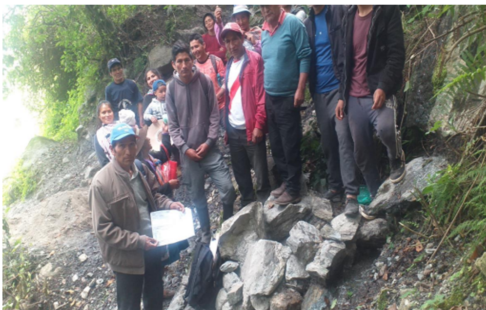
Se observa la Captacion construida afectando al CUA Yanacollpa-Pincapata
