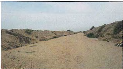
Foto 34: Fondo de la sección hidráulica con importante grado de colmatación.
