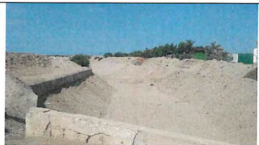
Foto 33: Vista aguas abajo tomada desde la panamericana antigua, se observa el grado de colmatación de la sección hidráulica.
