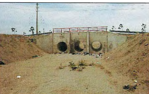
Foto 38: Alcantarilla recientemente construida sobre el cauce sur.
