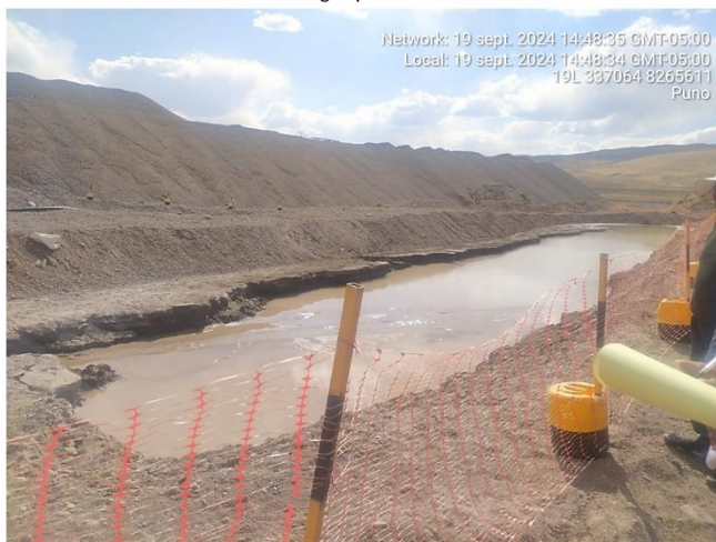
Vista de la poza de sedimentación donde se almacena el agua procedente del lavado de arena
