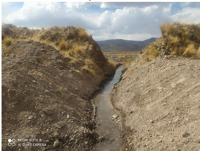
Vista del canal de evacuación de aguas residuales con dirección al río Cabanillas
