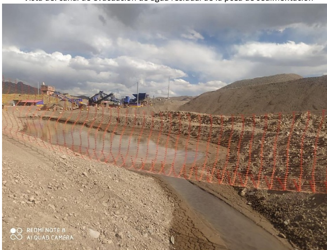
Vista del canal de evacuación de agua residual de la poza de sedimentación
