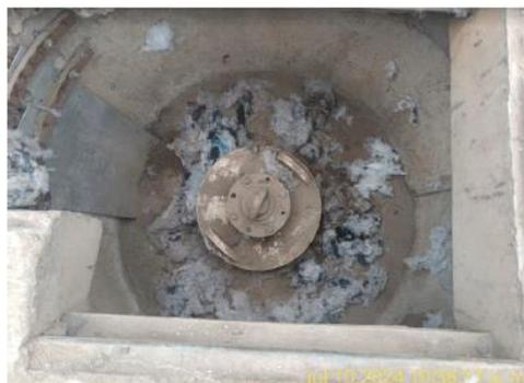
COORDENADAS, UBICACIÓN / POZO EN ESTADO UTILIZABLE CON TAPA SOLDADA
