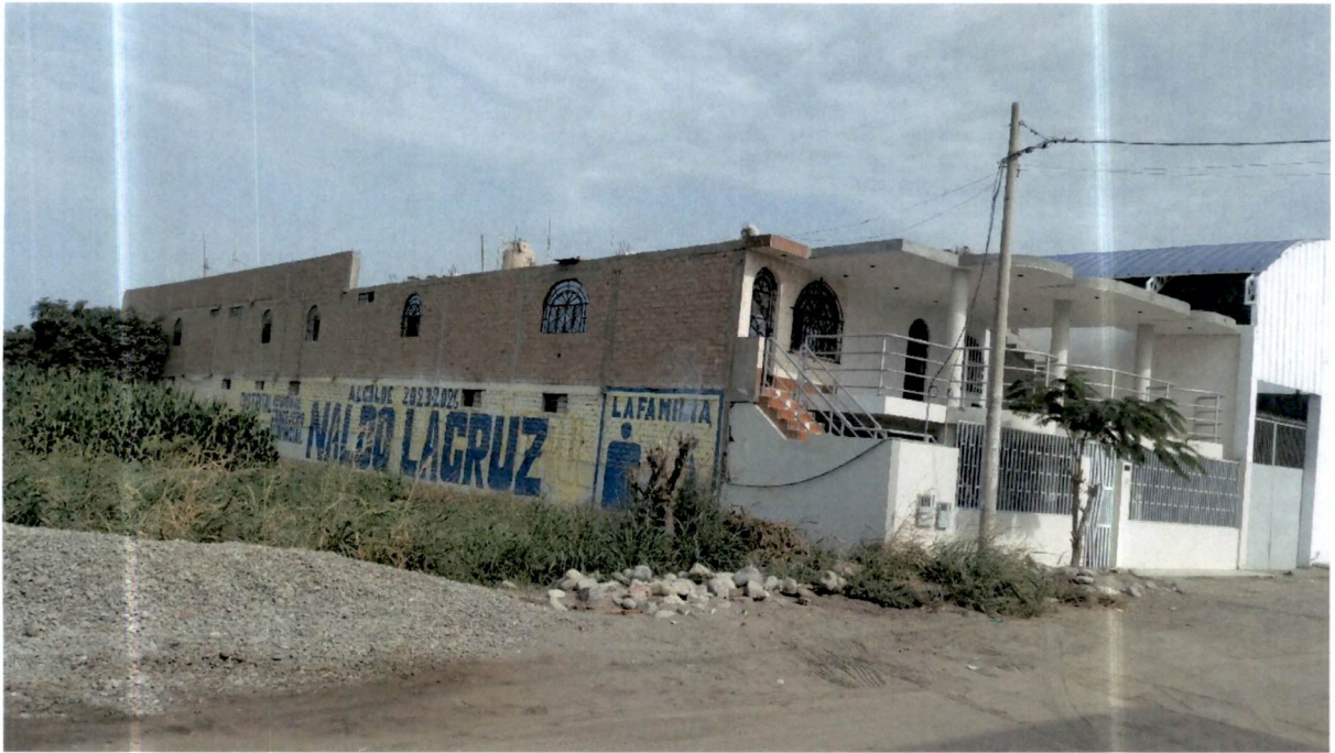
Imagen N°01: Se observa una casa de material noble de 22 m x 72 mt aprox. en la U.C.N° 32808
