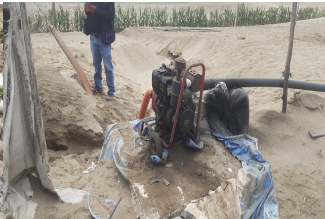
Motor y bomba instalada para el bombeo de agua de 16 HP
