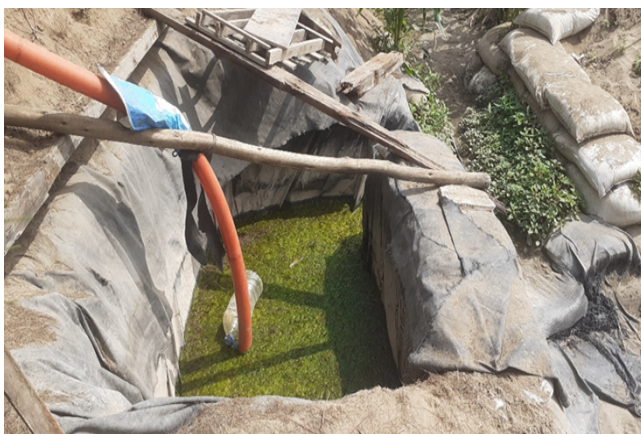
Captación de agua mediante manguera de succión de 3" de la margen derecha del canal F1 San Juan
