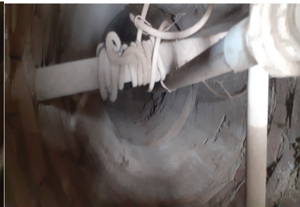
Pozo equipado con una bomba de 1HP tuberías de 1" PVC de succión y salida
