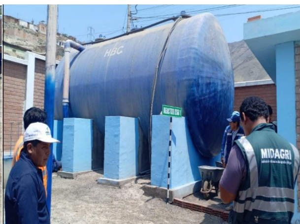
Imagen 2 Se Observa reactor de tratamiento biológico anaeróbico
