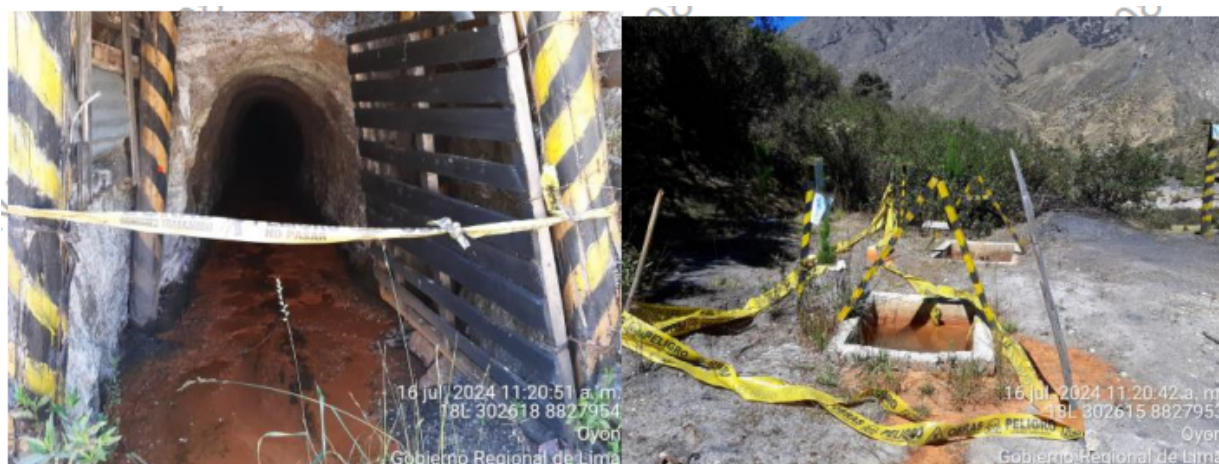
Fotografía N° 01(Izquierda). Vista de la bocamina Santa María. Fotografía N° 02(Derecha). Vista de las dos (02) pozas sépticas que se encuentran a unos metros de la Bocamina, se evidencia manchas de color anaranjado alrededor de las mismas.
