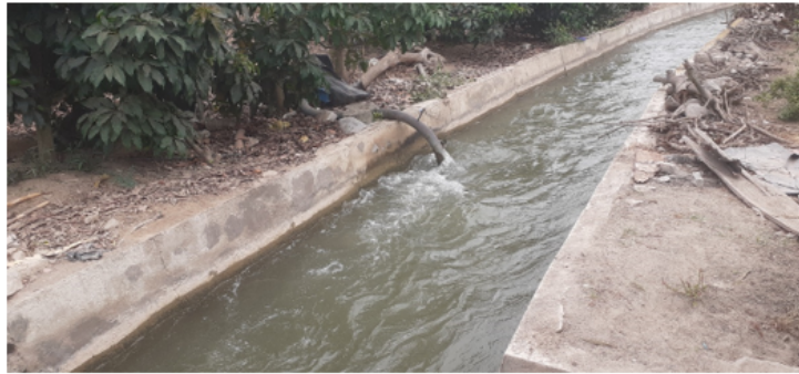
Manguera de 3" captando agua en el canal L1 Cabuyal
