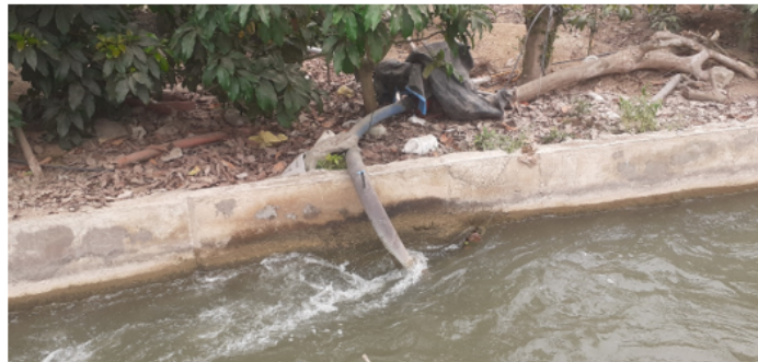
Bombeo con manguera de 3" y motobomba
