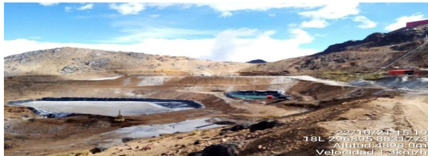
Foto N° 3 Cancha de relaves mineros Planta de Beneficio de la empresa Servicios Mineros E.I.R.LTDA.
