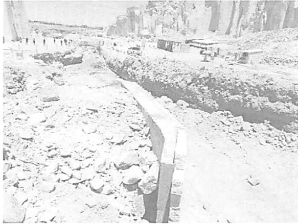
Anexo N° 05: Lugar 8M, construcción de muro de contención en el cauce de la quebrada.
