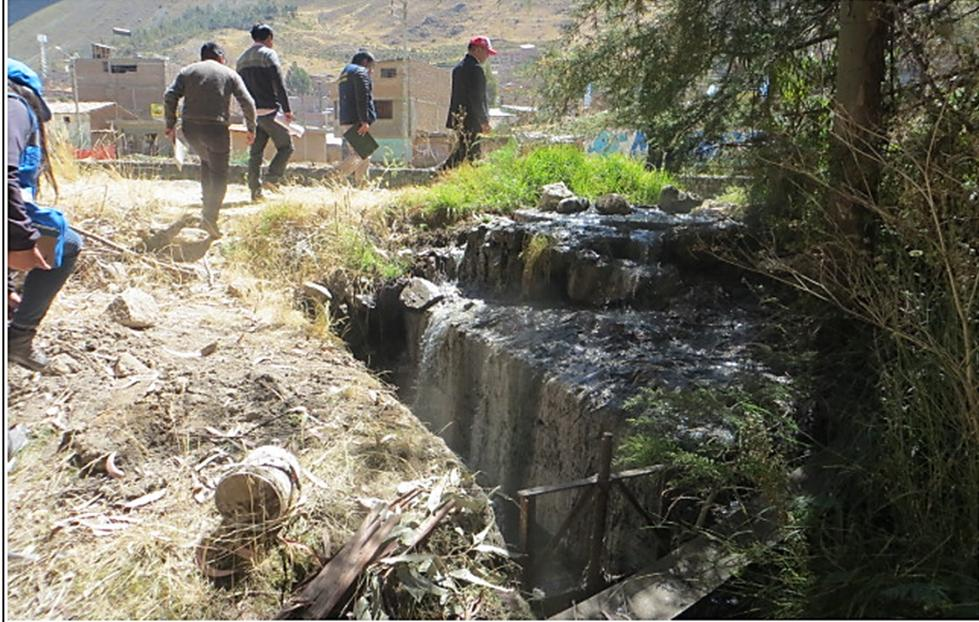
Fotografía N° 02: Vertimiento de aguas residuales, a través de una tubería de 12 pulgadas, hacia la margen derecha del río Ichu.
