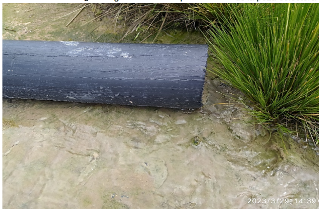
Foto N° 07: Descarga de aguas residuales provenientes de la poza colectora
