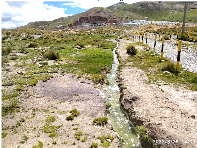
Foto N° 09: Canal en tierra formado por las aguas residuales
