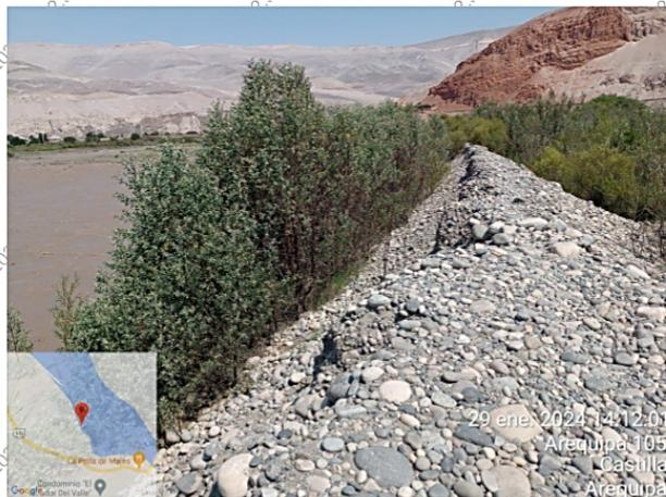
Detalle del prisma o dique irregular antiguo, en zona con erosión hídrica.
