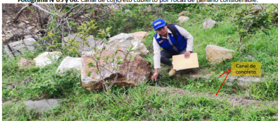
Fotografía N°05 y 06. Canal de concreto cubierto por rocas de tamaño considerable.
