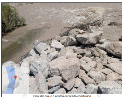
Final del dique o prisma enrocado construido.
