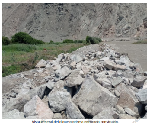
Vista general del dique o prisma enrocado construido.
