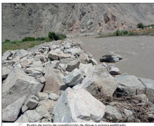
Punto de inicio de construcción de dique o prisma enrocado.
