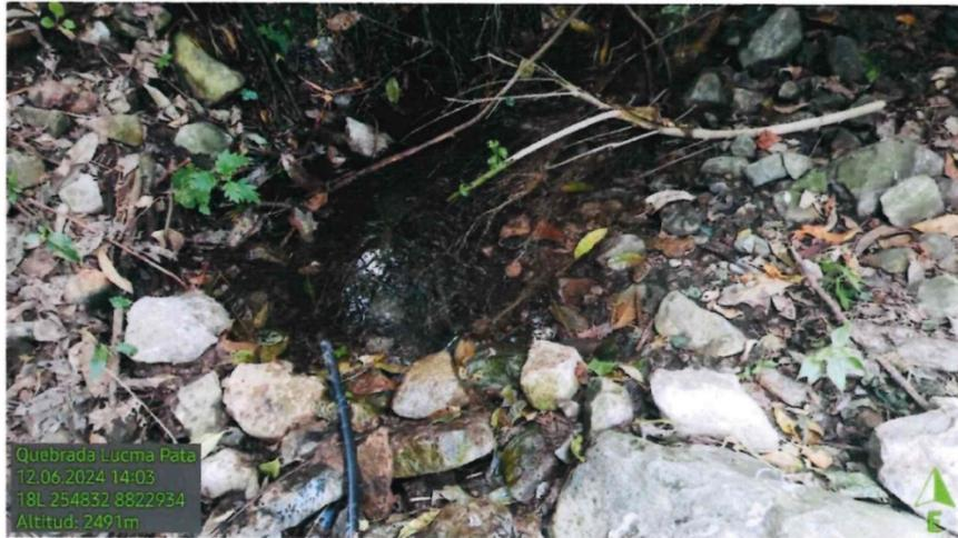
Imagen N° 1: Vista de la captación mediante toma directa con tubería HDPE de 1 1/2" en la margen derecha de la Qda. Lucma, sector Lucma Pata, distrito de Manas, provincia de Cajatambo-Lima
