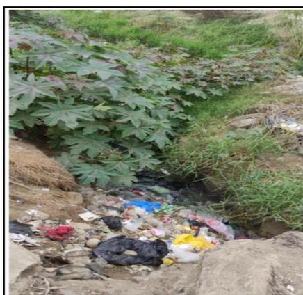
2. Recorriendo este dren s/n, se observa que recientemente, han realizado limpieza de una margen de este dren, también se observa que las aguas represadas debido a que la salida del dren esta colmatada tal como se mencionó en el párrafo anterior. Ver Imagen.
