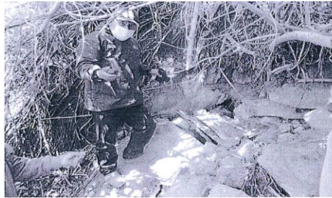
Construcción de captación de concreto en el manantial Yuraccrumi 1, aguas arriba (300 m) del manantial Hueccencca Manzanayocc
