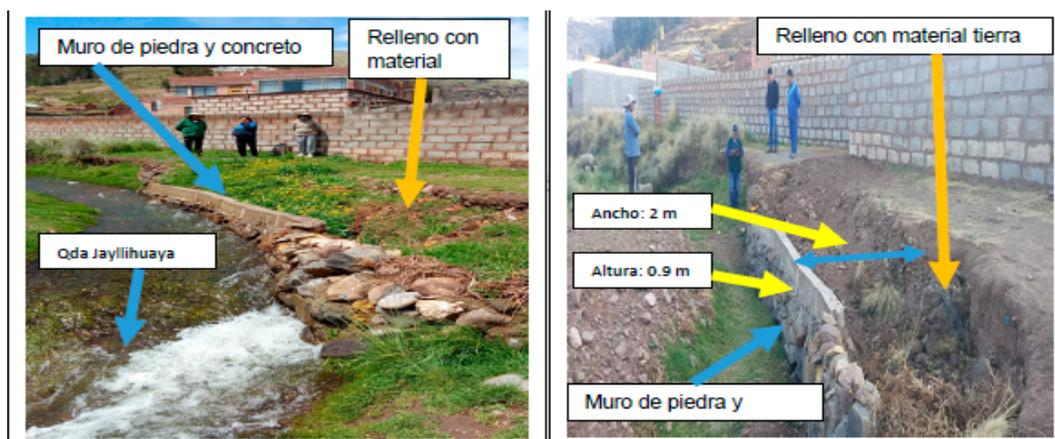
**Fotografía 1:** (VTC fecha 21.02.2025). ubicación y georeferenciación sobre la ocupación de cauce con relleno material tierra y con las precipitaciones creció pasto natural y el muro de concreto y piedra emplazado en el cauce, ubicada en la coordenada UTM Datum WGS 84 Zona 19 S. Este: 396012 m v
