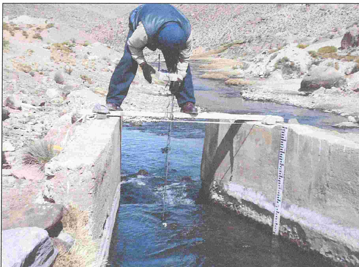
Fotografía Nº 7: Estación Hidrométrica Salida de Represa Jarumas.
