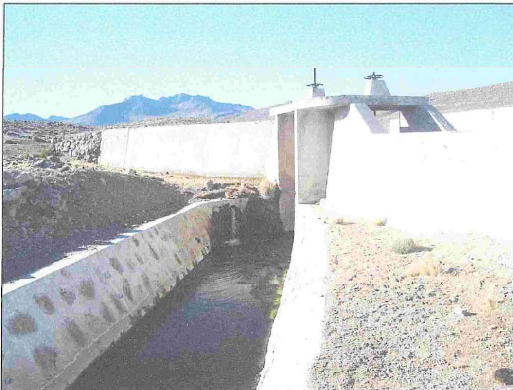
Fotografía N° 5: Canal Quequesane que tiene una capacidad de conducción de hasta 3.5 m 3 /s.
