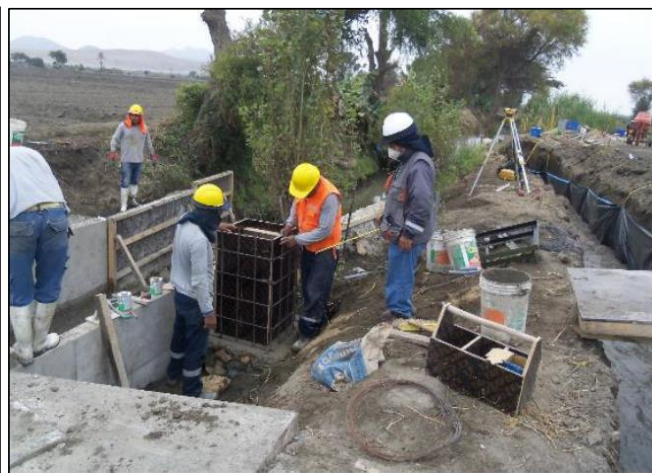
Encofrado de las caras internas con paneles fenólicos, para obtener un acabado caravista, en la zona de la caja de alojamiento de equipos, Canal San Bartolo - JUSHM Santa
