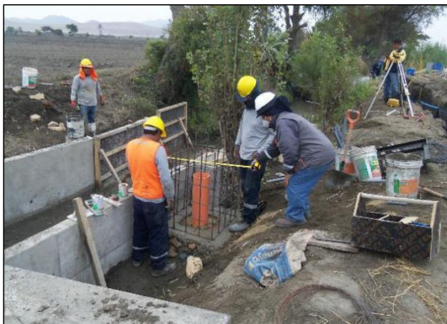
Acero de refuerzo F_y=4200 \text{ kg/cm}^2 , en la zona de la caja de alojamiento de equipos, Canal San Bartolo - JUSHM Santa
