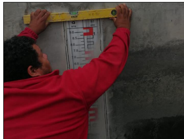
Nivelación de regla de mármol
