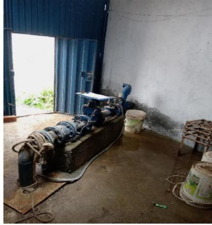
**Pozo tubular IRHS 153 equipado con bomba sumergible con su respectivo tablero de control.**
