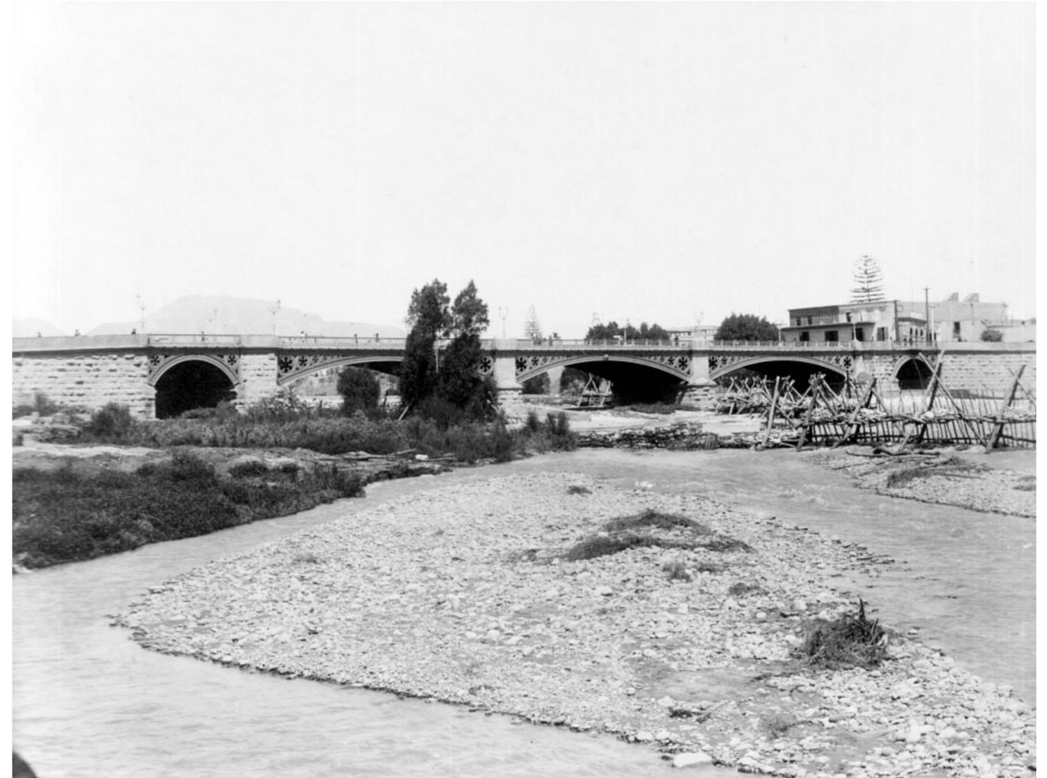
*Encausamiento del Río Rímac. Nuevo cauce canalizado cerca a la desembocadura en el puente de San Agustín. Vista de los taludes defendidos con escolleras de grandes rocas y muro de concreto de encauzamiento.*
