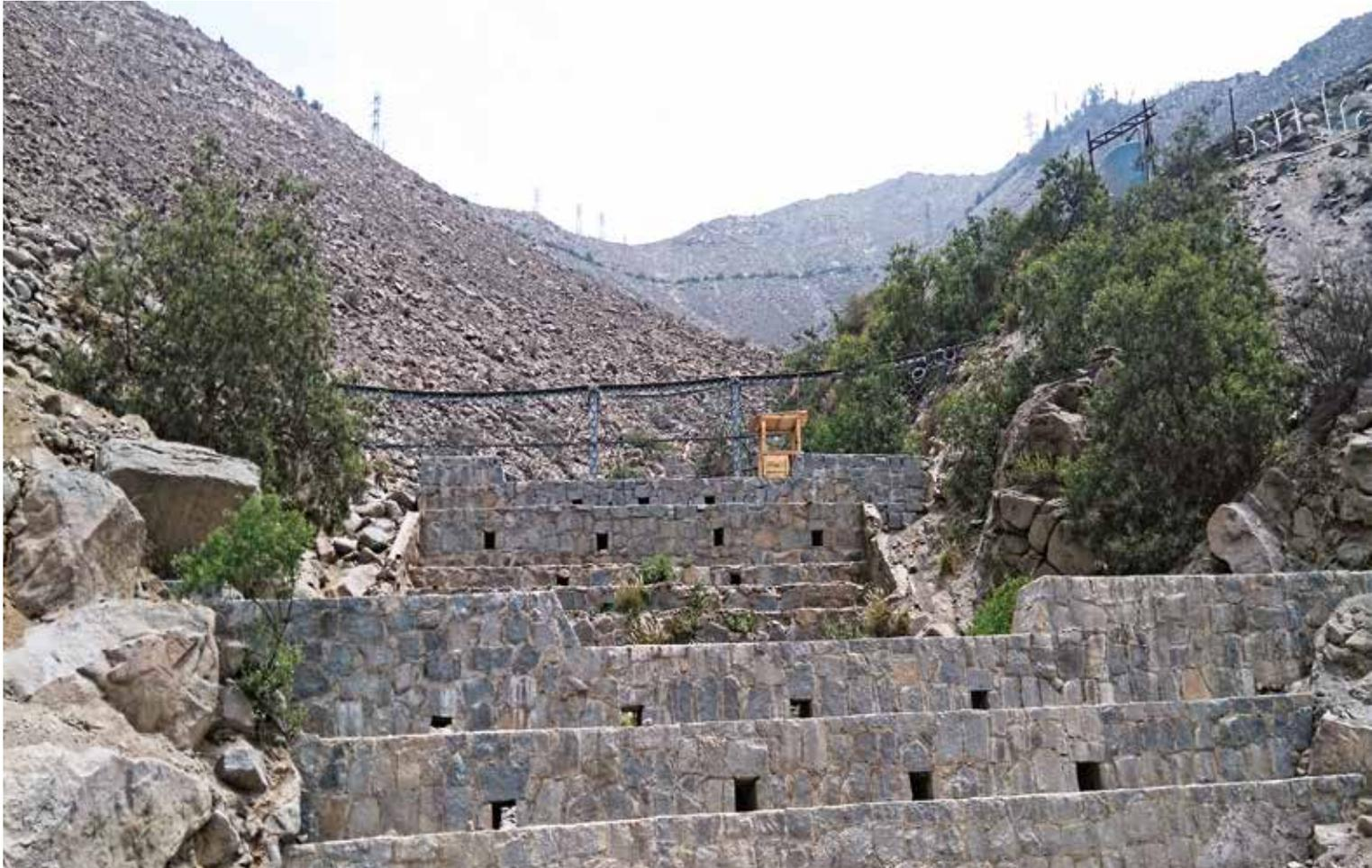
Combinación de Malla Dinámica con muros transversales de roca.
