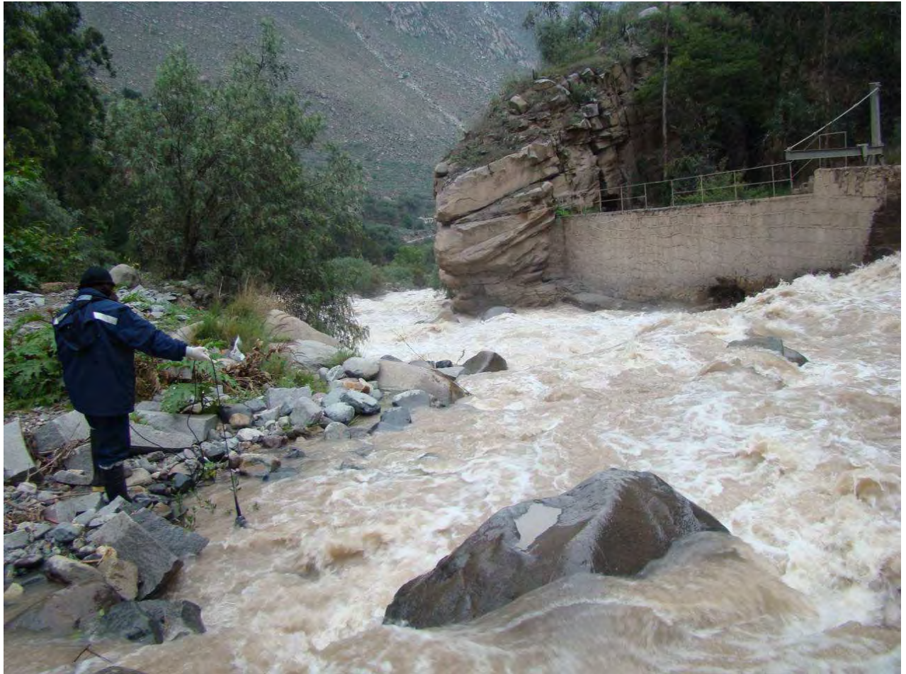
E-10: Río Rímac, aguas abajo de puente Surco, Carretera Central Km 66.
