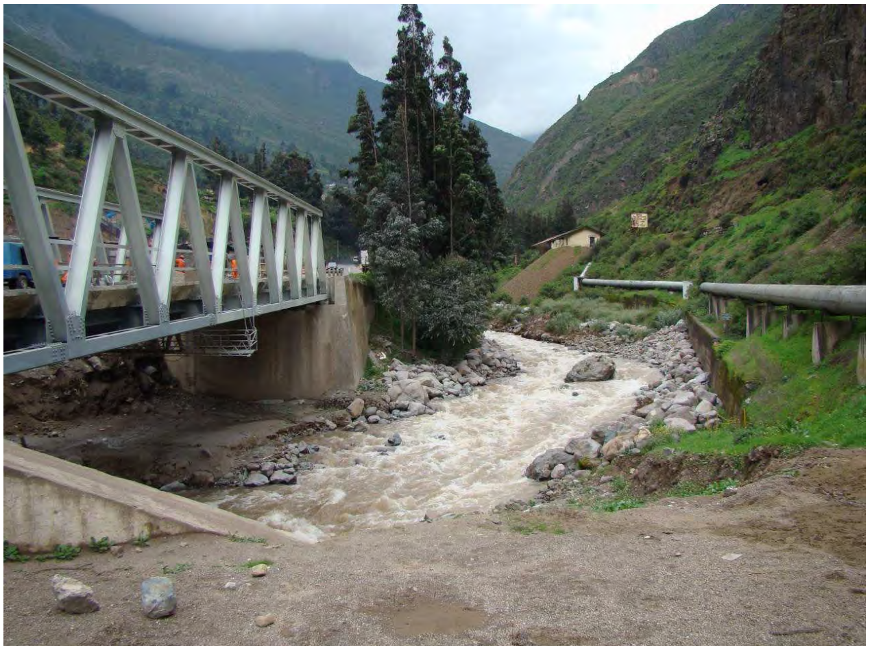
E-06: Río Rímac, puente Tamboraque III, Carretera Central Km 90,6 (vista panorámica).
