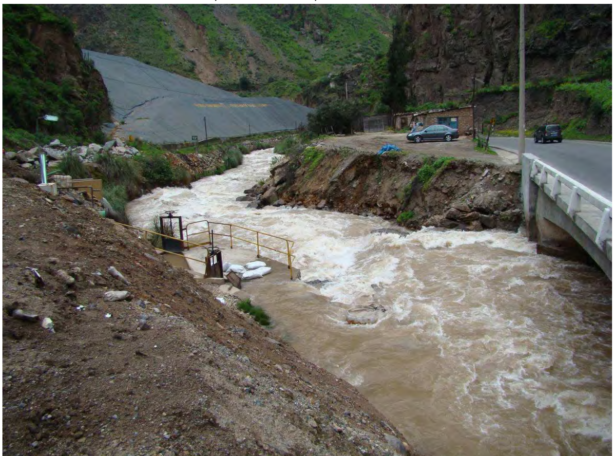
E-6A: Río Rímac, Central Hidroeléctrica Huanchor (Puente Tamboraque II).
