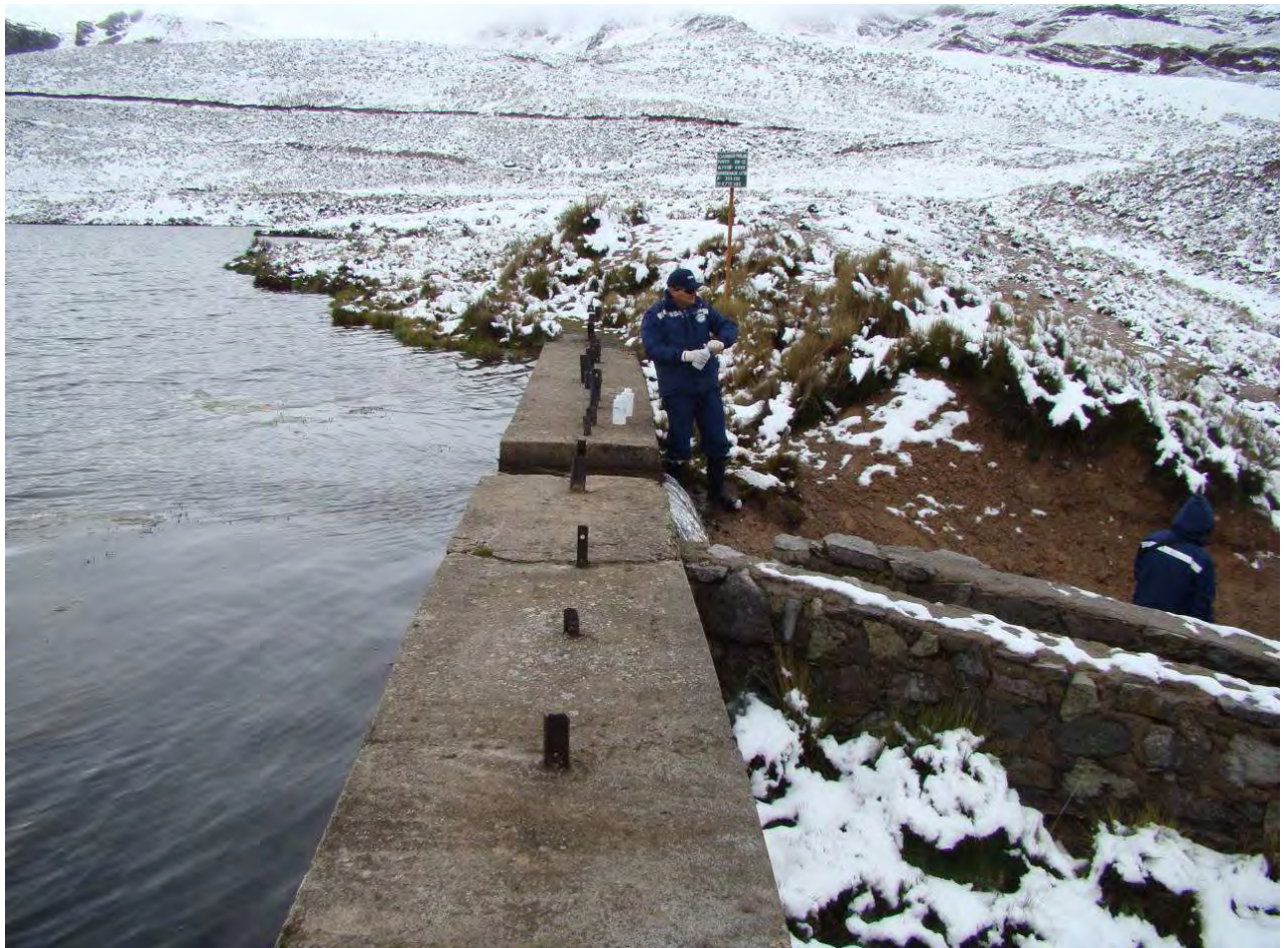
Laguna Ticticocha, vista de la presa de concreto.
