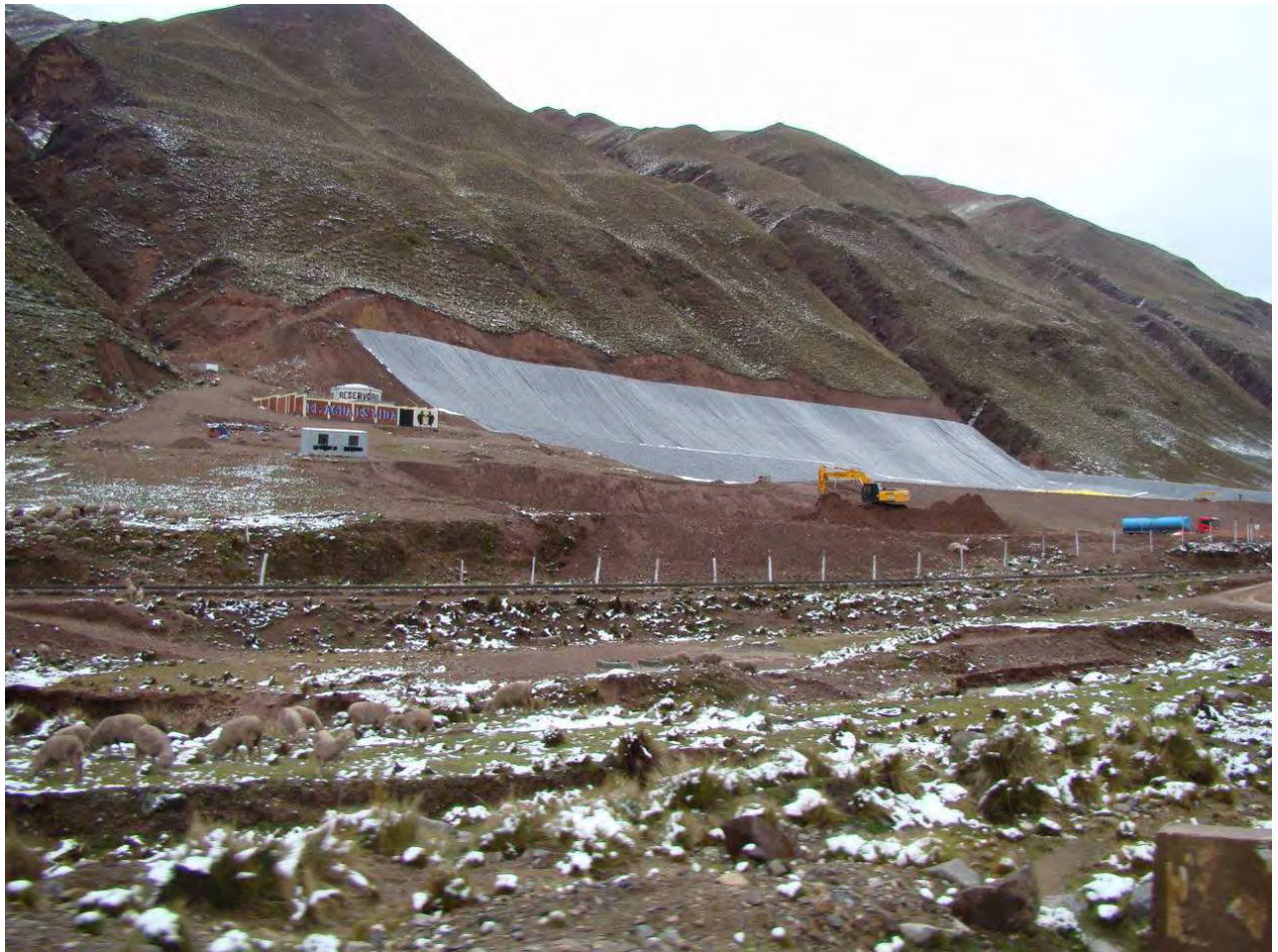
Geomembrana (cubierta) del nuevo depósito de relaves de Compañía Minera San Juan (Perú) S.A.
