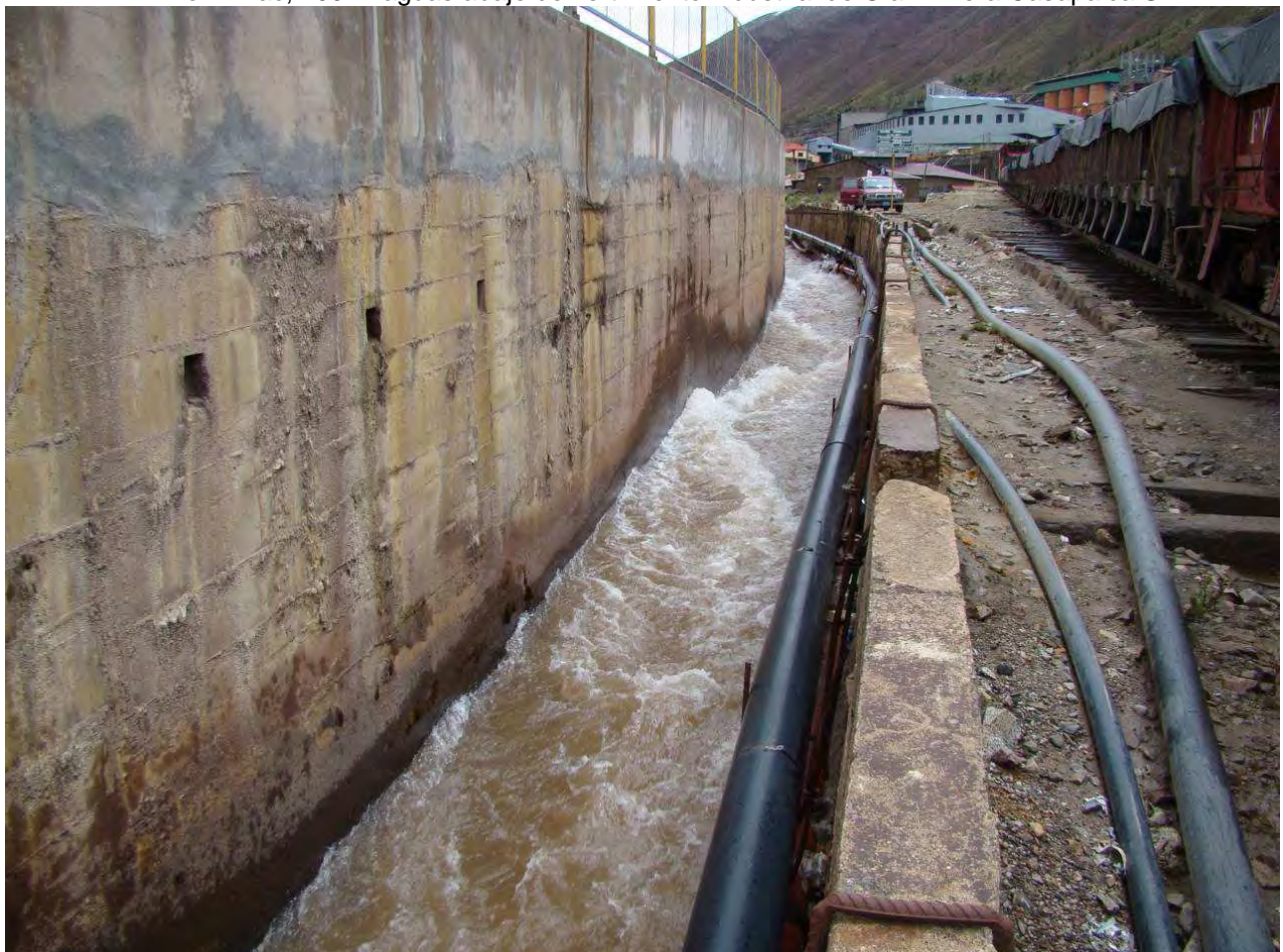
E-2B: Río Rímac canalizado con concreto al borde de Casapalca.
