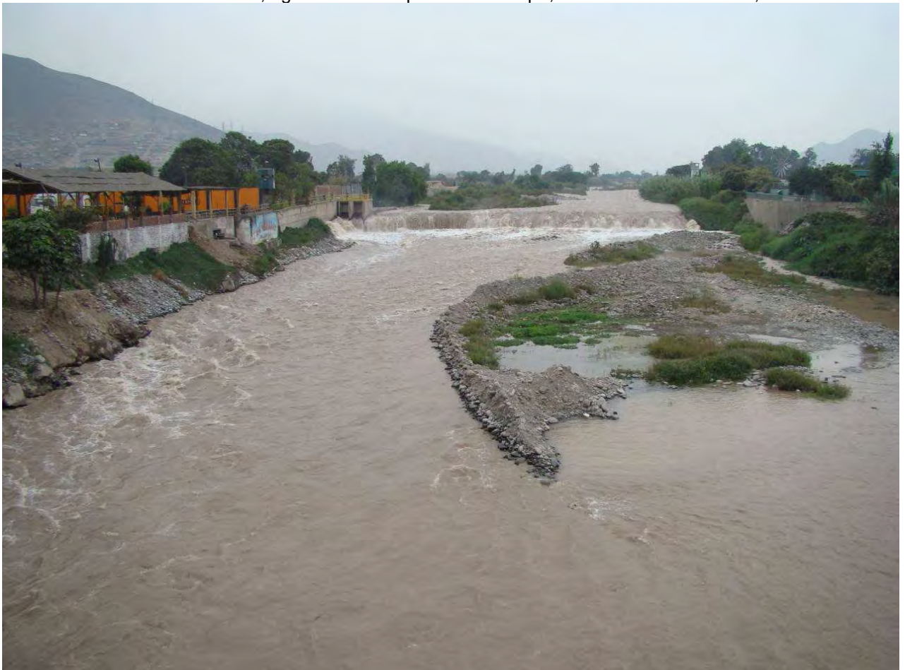
E-16: Río Rímac, aguas arriba de puente Huachipa, Carretera Central Km 9,5.
