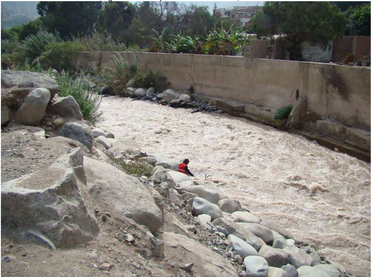
E-11: Río Rímac, aguas arriba de puente Ricardo Palma, Carretera Central Km 38.
