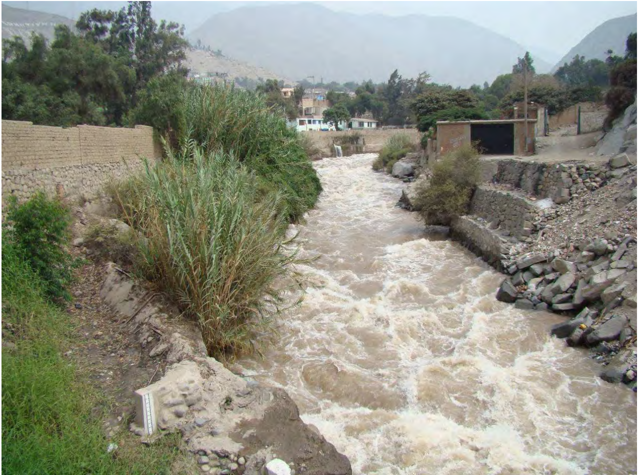
E-13: Río Santa Eulalia, puente ubicado antes de la confluencia con el río Rímac.
