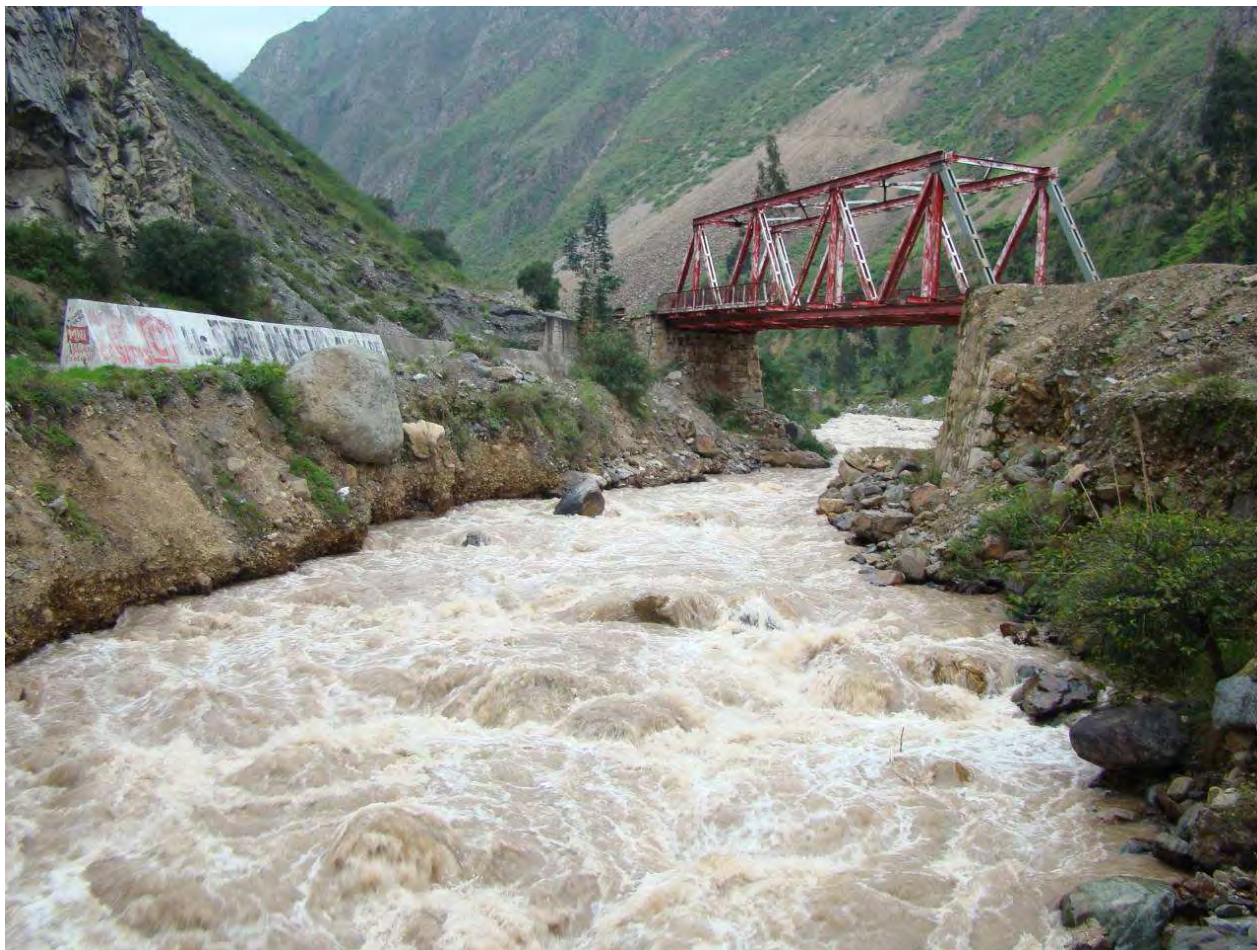
E-09: Río Rímac, puente Tambo de Viso, Carretera Central Km 83,5.
