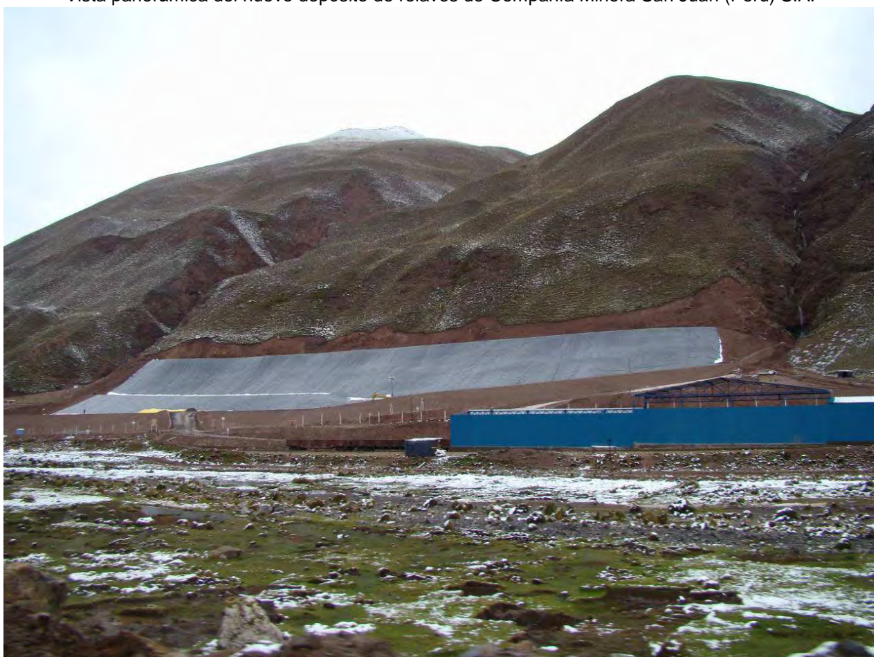
Nuevo depósito de relaves, ubicado en la margen derecha del río Chinchán.
