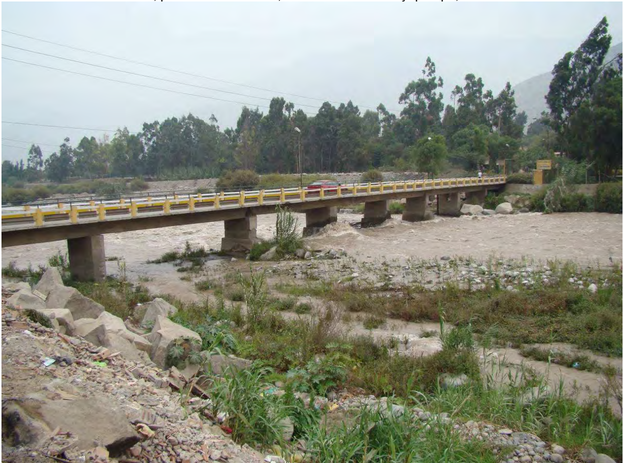
E-15: Río Rímac, puente Morón, Carretera Central Km 23.
