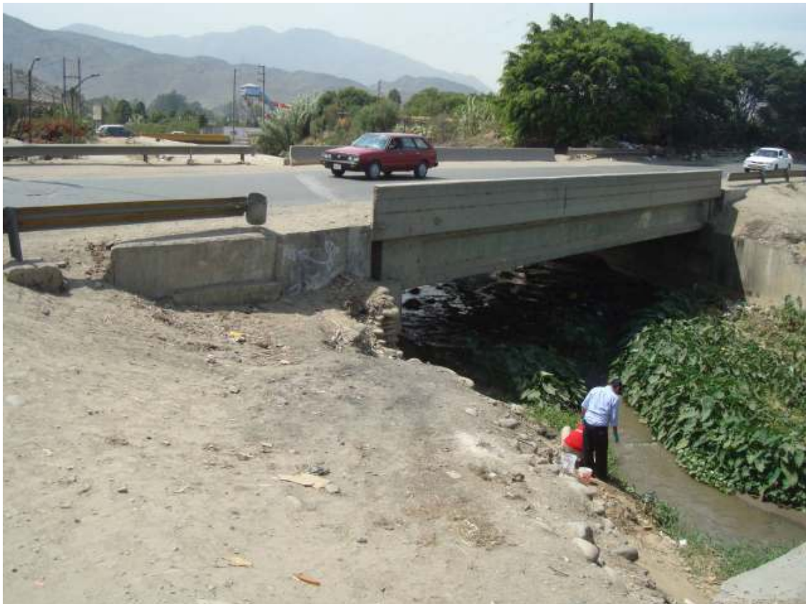
E-17: Río Huaycoloro, antes de la confluencia con el río Rímac.
