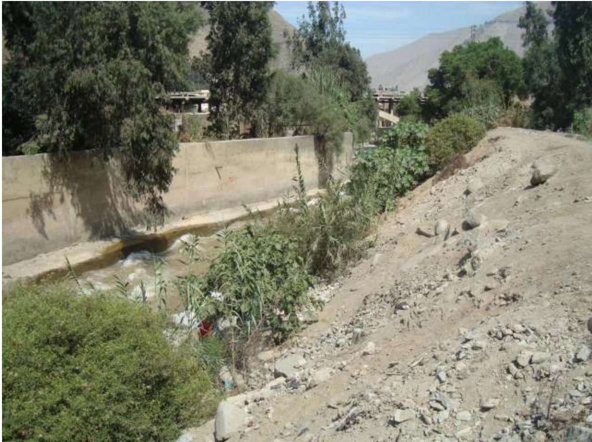
E-11: Río Rímac, puente Ricardo Palma, Carretera Central Km 38.
