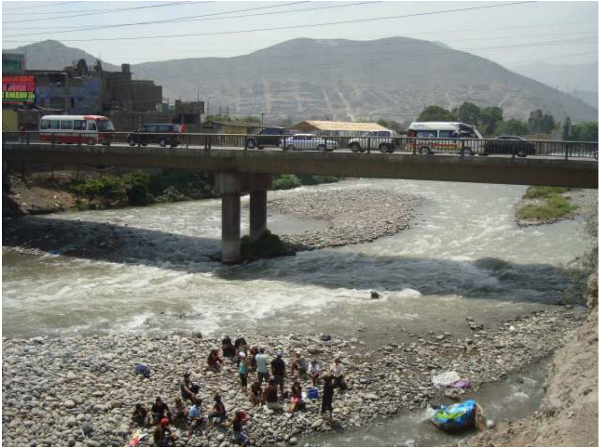
E-16: Río Rímac, puente Huachipa, Carretera Central Km 9,5.
