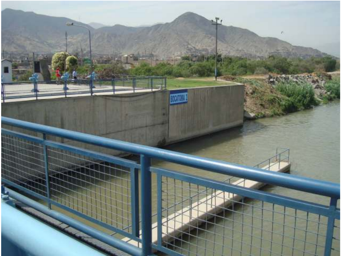
E-25: Río Rímac, Bocatoma 2 - La Atarjea.
