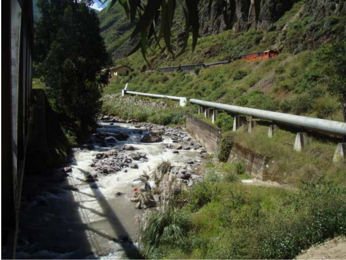
E-06: Río Rímac, puente Tamboraque III, Carretera Central Km 90,6.
