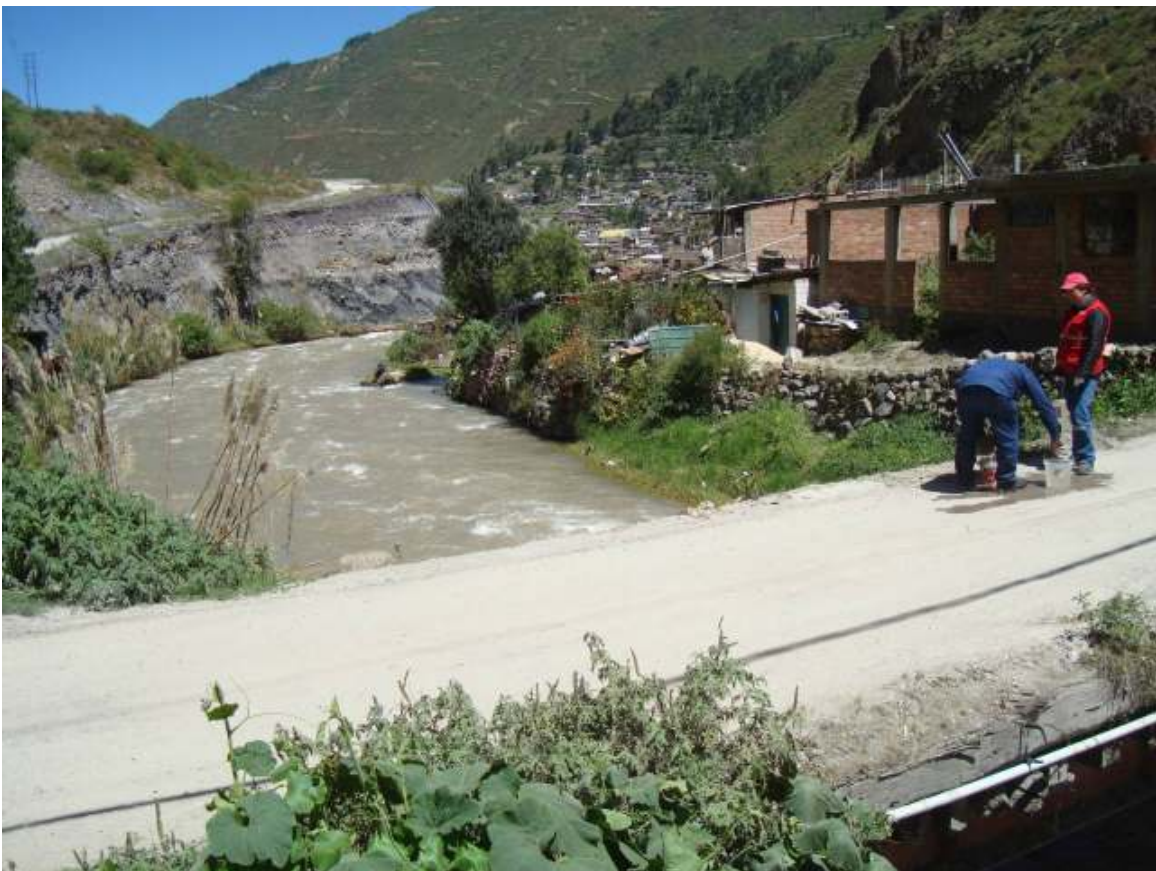
E-05: Río Rímac, puente Pite, Carretera Central Km 95.
