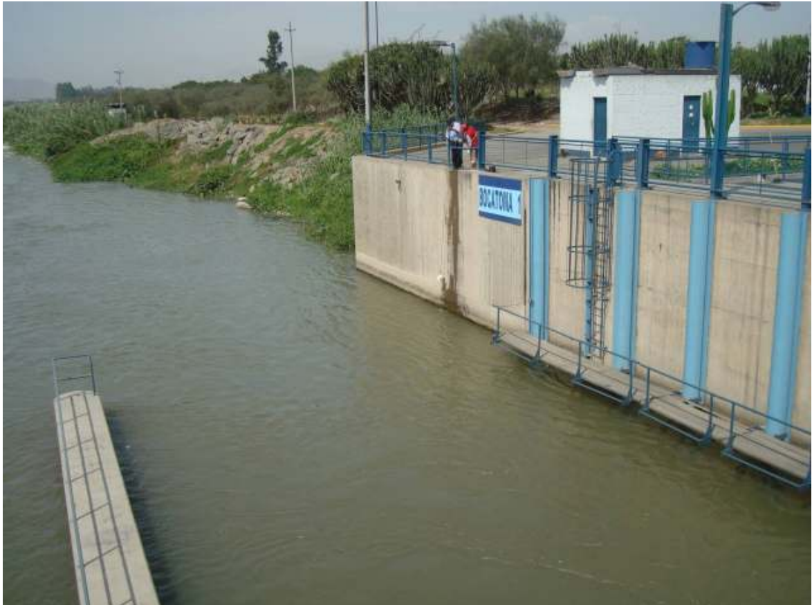
E-24: Río Rímac, Bocatoma 1 - La Atarjea.
