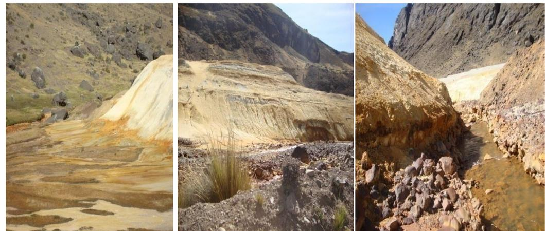
Relavera abandonada. Filtración de la parte inferior (izq.), talud deslizado (med.) y talud que limita con el cauce (der.) Río Aruri.
