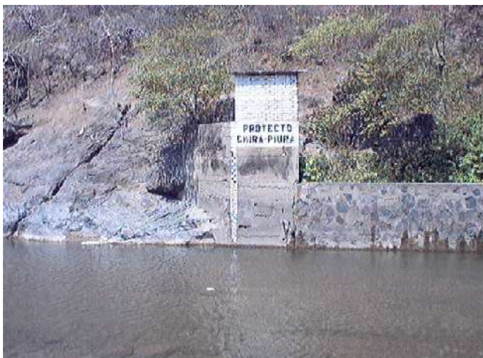
Foto 01. Instalación limnigráfica río Quiroz – Estación Paraje Grande
