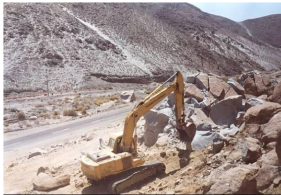
Fig. N° 04: Extracción de roca sin explosivo
