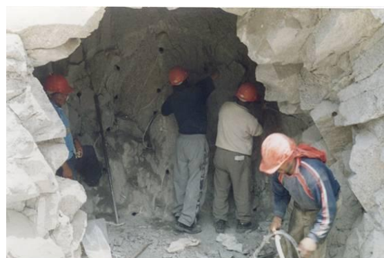
Fig. N° 05: Extracción de roca con explosivos
