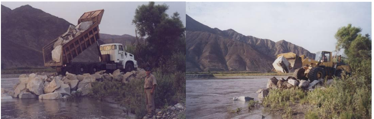
Fig. Nº 10: Conformación de defensa ribereña
