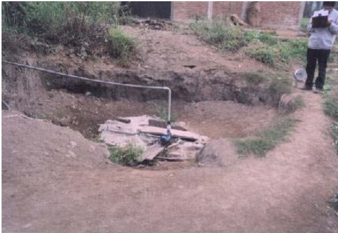
FOTOGRAFÍA N° 16 Pozo tajo abierto equipado.
