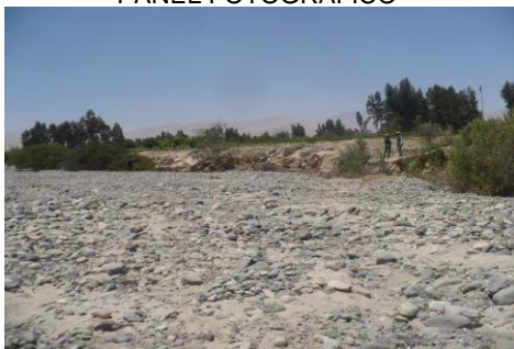
Vista fotográfica del tramo crítico ubicado en la margen izquierda del río Caplina, jurisdicción del distrito de Pachía, provincia de Tacna, como se observa en la foto, requiere proteger las áreas de cultivo y otros.
